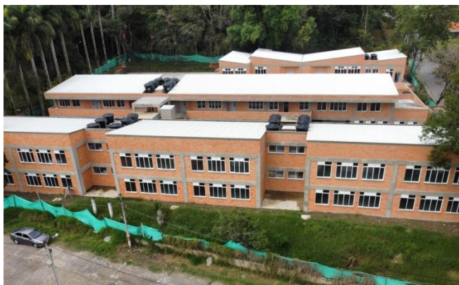
Pendiente Conexión final red de gas a cargo de la ET
