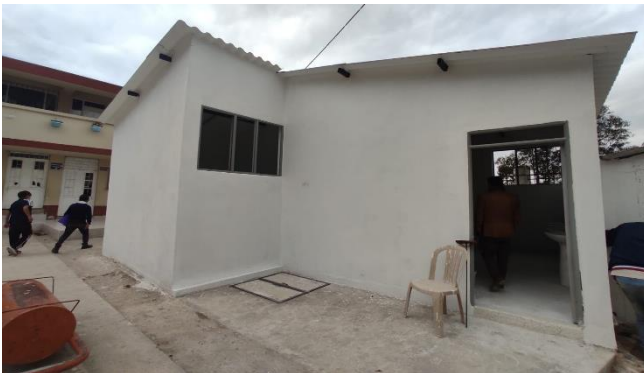
Terminada Unidad Sanitaria en construcción pozo séptico
