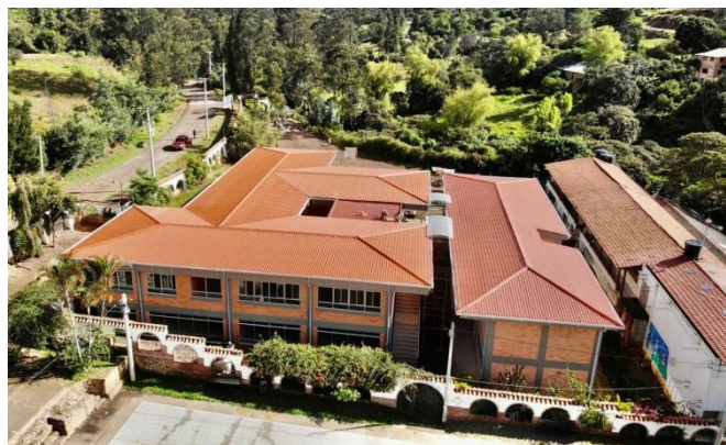
Conexión final de energía a cargo de la ET
