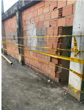
Gráfica 09: Cerramiento de la infraestructura
