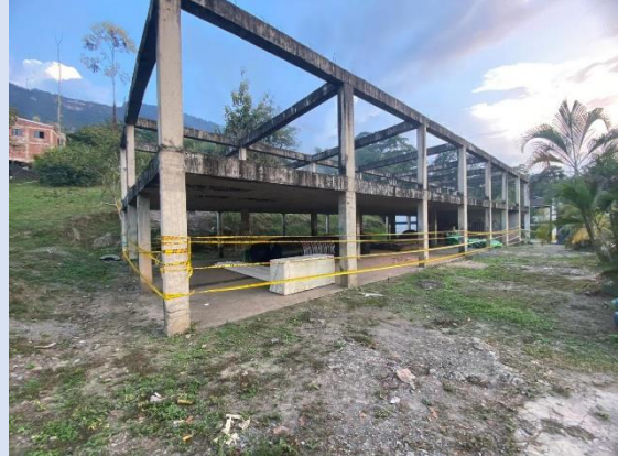
Gráfica 12: Cerramiento de la infraestructura
