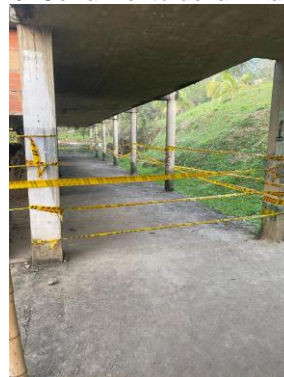
Gráfica 10: Cerramiento de la infraestructura
