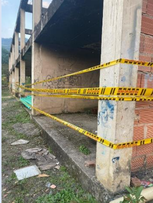
Gráfica 11: Cerramiento de la infraestructura
